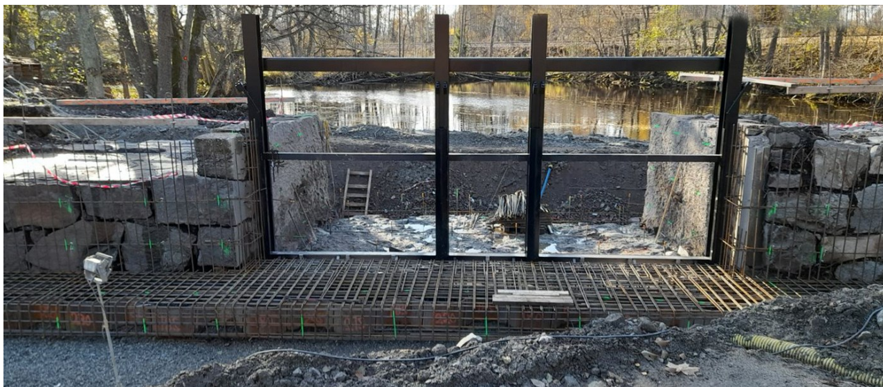
Låt nya dammluckorna bli vårt fönster mot framtiden!
